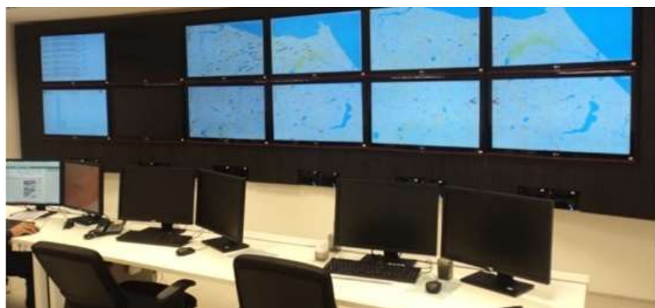
Figura 12: Possível Painel de Monitoramento em tempo real (sala situacional)
